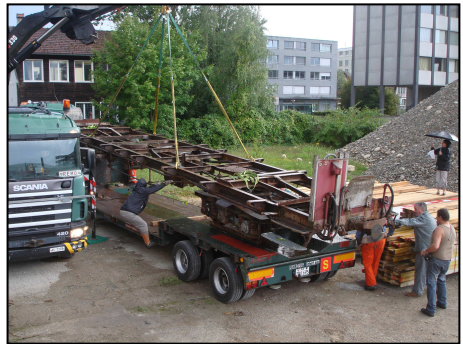
Transport des „Brombeerchassis“ in die neue Wagenwerkstatt
